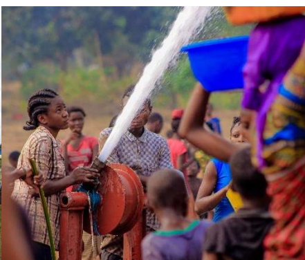
Test lors des essais de pompage
