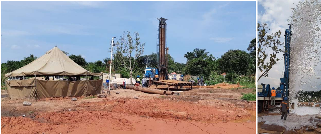
Travaux de forage en cours en 2020-2021 par l'entreprise Solutions for Africa
