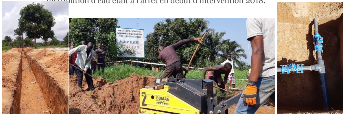
Travaux de réhabilitation lié à de la pose conduite des réseaux d'eau potable
