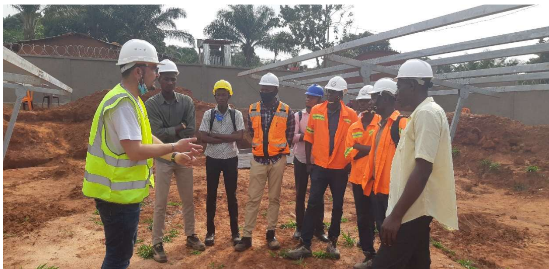
Formation aux techniciens des ASUREP pendant la phase de travaux avec l'entreprise
