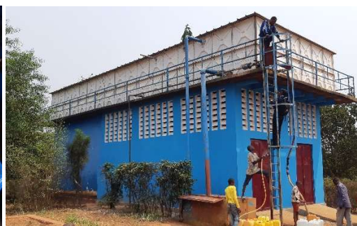
Dépôt réalisé sous un château d'eau
