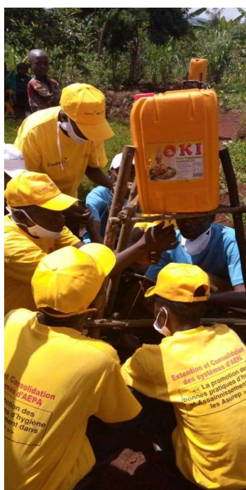
Mise en œuvre de dispositifs de lavage des mains avec les populations du réseau Mwendo- Mudaka avec le support de Caritas. Ces dispositifs permettent d'utiliser de faible quantité d'eau pour se laver les mains sans manipuler le robinet. L'ouverture s'effectue à l'aide d'un dispositif au pied
