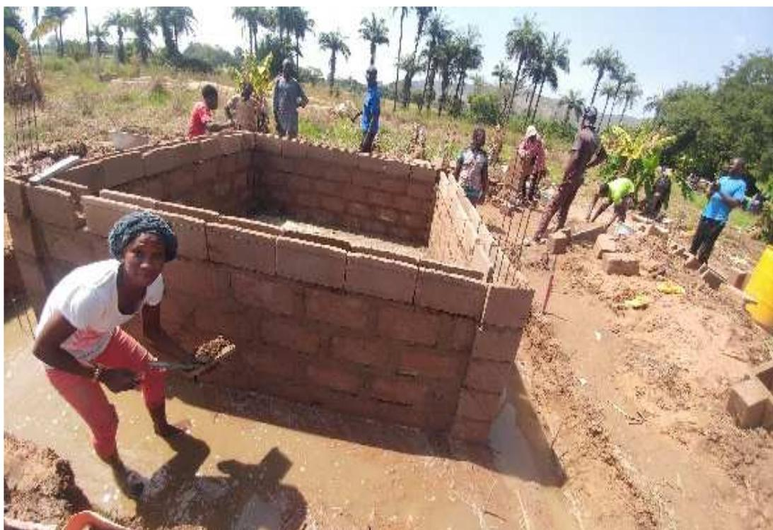
**Photos N° 3** Formation, des maçons, dont une maçonne de Boukoubbé ! aux techniques de construction des bassins, en utilisant des formes de briques préconstruites, pour les angles et les chainages
