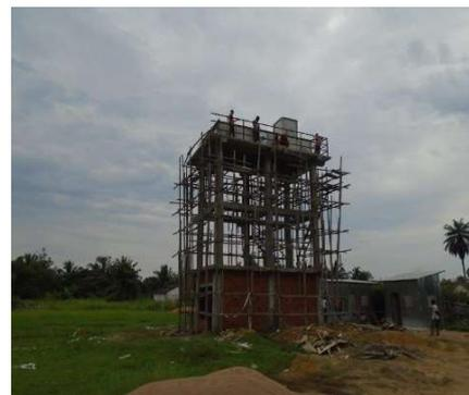
Château d'eau de Katako avec sa cuve de 18 m<sup>3</sup> montée
