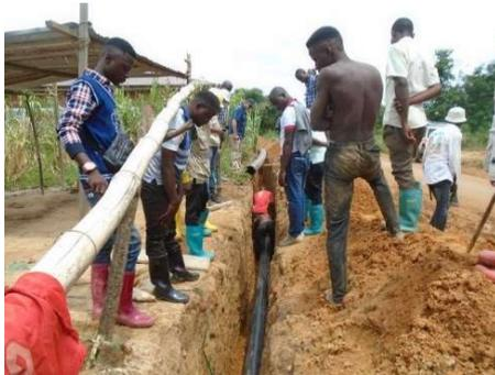
Pose des conduites PVC à joint Ø 200 refoulement -
