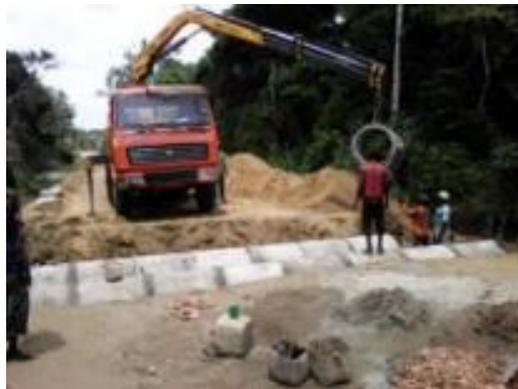
*Photo 42: Pose d'une batterie de buses par l'(OR) sur la digue de Ndana, axe Bagata / Mabenga.*
