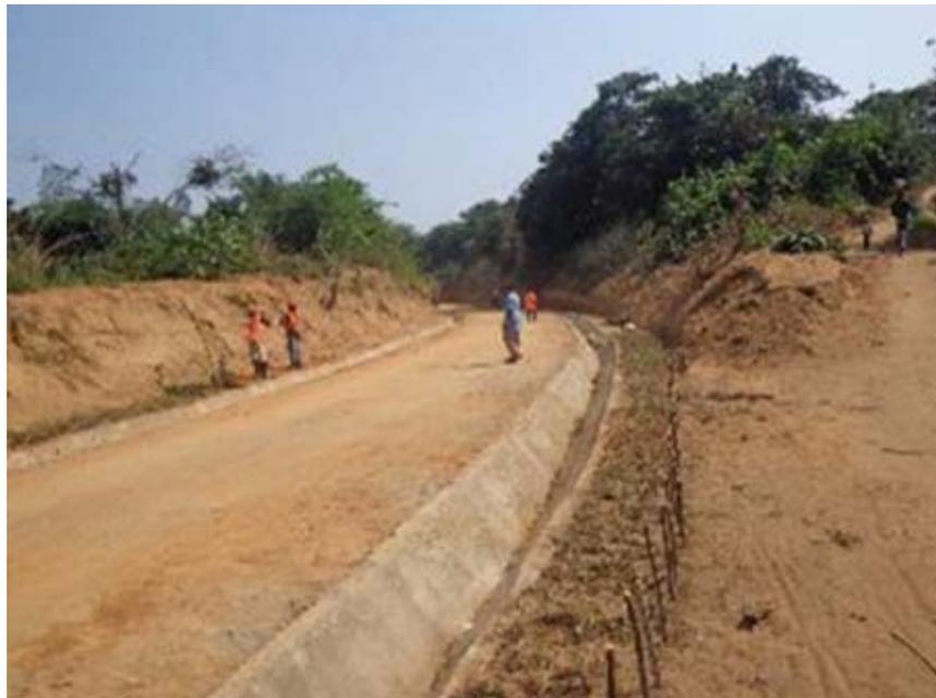
Photo 36: Traitement des points chauds sur l'axe Mikambo / Bongo-Yassa (Réalisation d'un sol ciment et de fossés en béton).
