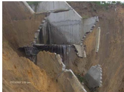
*Erosions Mataba : rupture de la glissière après les pluies (photo CI2007)*
